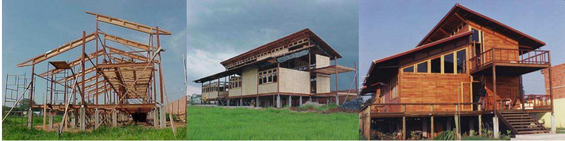
Figura 1 – IMAFLORA I - Montagem da estrutura, vedação e acabamento. Fonte: Elaborada pelos autores.
