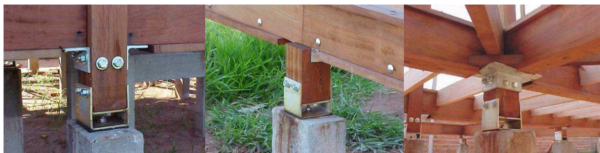
Figura 3 – IMAFLORA I – Interfaces pilar-fundação e pilar-viga composta. Fonte: Elaborada pelos autores.
