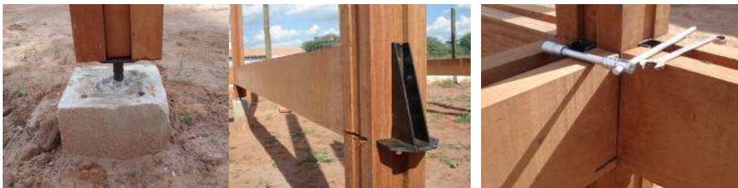
Figura 9 – IMAFLORA I – Interfaces pilar-fundação e pilar-viga executadas em obra. Fonte: Elaborada pelos autores.
