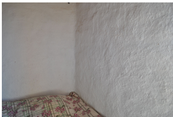
Figura 15: reboco com a segunda camada finalizada
