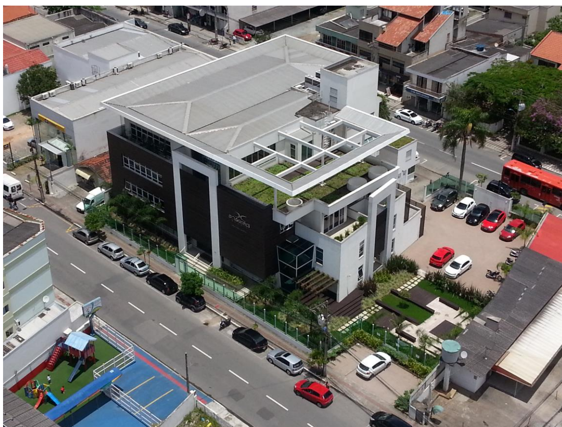
Figura 1: Vista superior do edifício DC Logistics Brasil. Fonte: Elaborado pela autora
