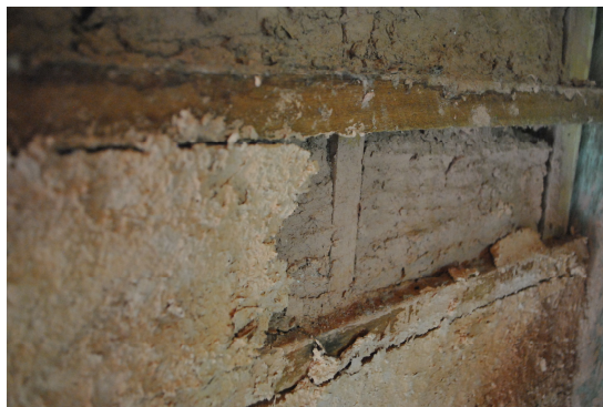
Figura 9: reboco com espessura de 1cm a 1,5cm devido a necessidade de regularizar a parede.
