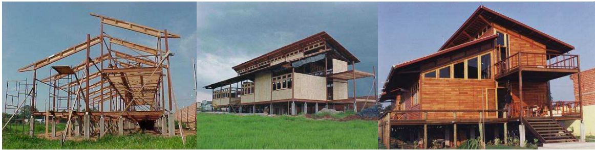
Figura 1 – IMAFLORA I - Montagem da estrutura, vedação e acabamento. Fonte: Elaborada pelos autores.
