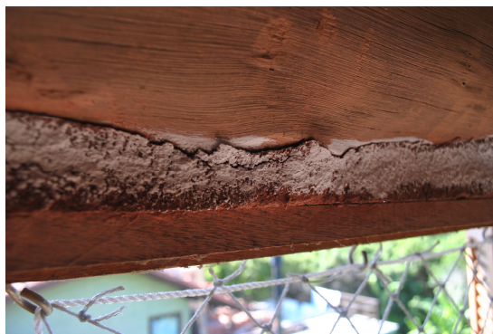
Figura 11: Local onde o reboco teve pouca aderência
