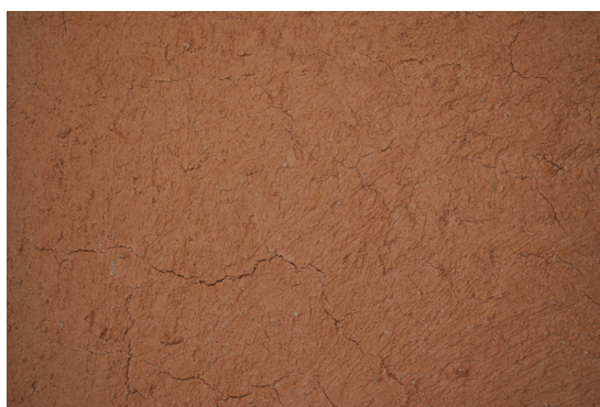
Figura 13: primeira camada do reboco com pequenas rachaduras, estável há dois anos.
