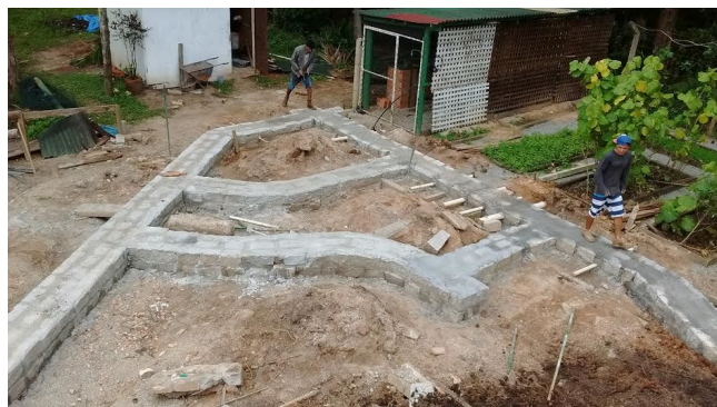
Figura 3: Construção das fundações da Casa do Chá.
