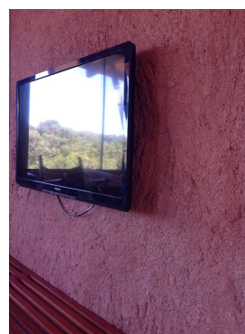
Figura 14: resistência da parede com primeira camada de reboco para sustentação de televisão
