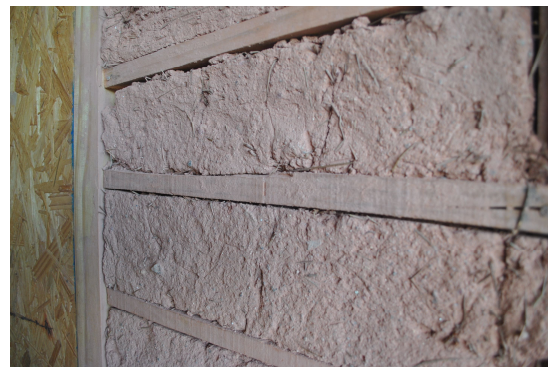
Figura 10: parede regular, com preenchimento rente à face externa da trama horizontal.
