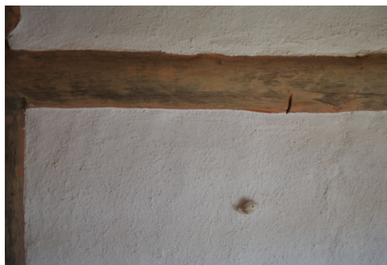
Figura 15: reboco com a segunda camada finalizada
