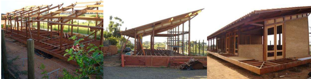
Figura 4 – IMAFLORA II - Montagem da estrutura, vedação e acabamento. Fonte: Elaborada pelos autores.
