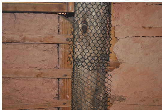
Figura 12: uso de tela plástica para melhorar aderência do reboco
