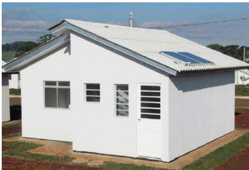
Figura 2: HIS construída com Light Steel Frame no conjunto habitacional “Jardim Amália” Fonte: arquivo dos autores.
