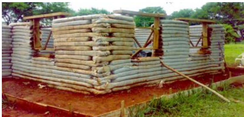
Figura 4: Construção utilizando-se de materiais naturais - Superadobe. Fonte: PortalVirtuhab (2016).
